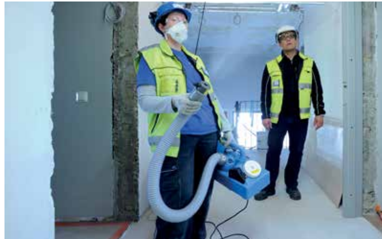
Vesisumutus on tehokas pölynhallinnan keino rakentamisen aikana. (Kuva ei liity Pohjola Sairaalan rakentamiseen.)
